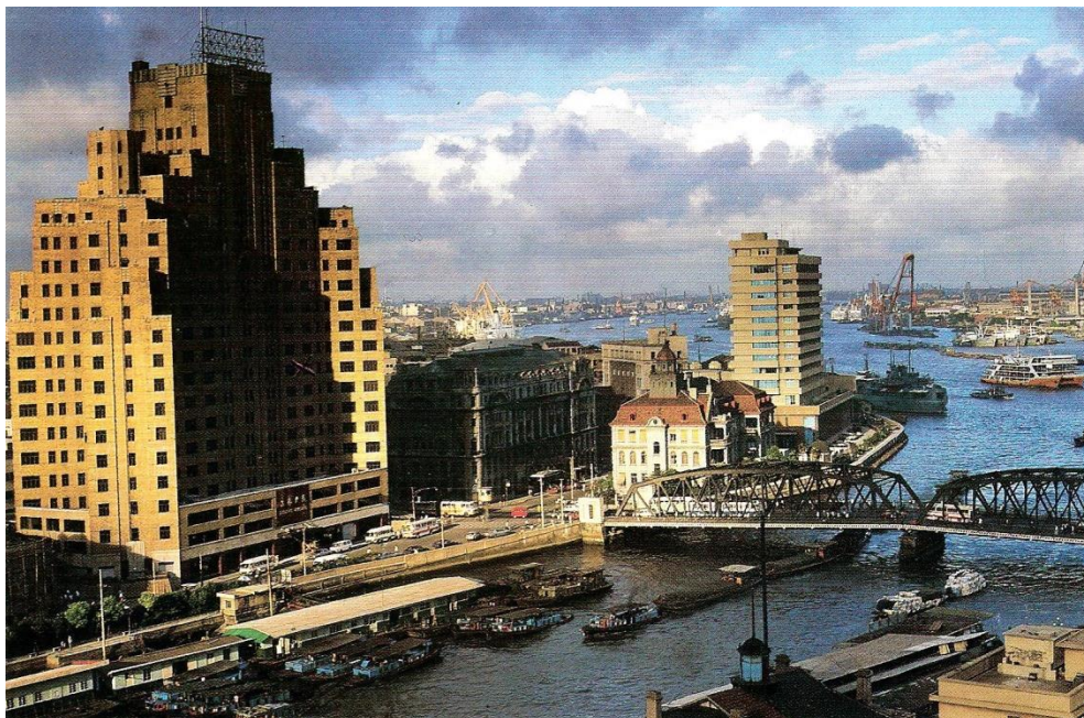
Hotel Shanghai Mansions (links im Bild) mit Blick zum Hafen, rechts die Brücke, die zum Bund führt (Postkarte)
